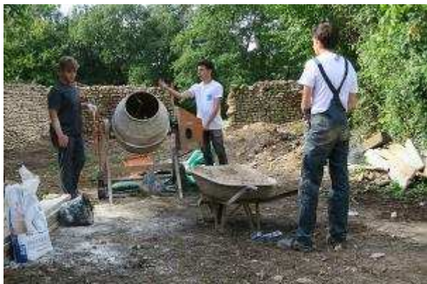
Les travaux en cours
